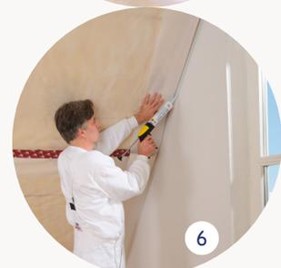
**Hinweis:** Die Lage der Spannfalze und der mit Klammern befestigten Dampfbremse ist mechanisch zu sichern (bspw. durch die Unterkonstruktion der inneren Bekleidung). Außerdem ist die Dampfbremse durch eine nachfolgende Bekleidung vor dem UV-Anteil des Lichtes zu schützen.
