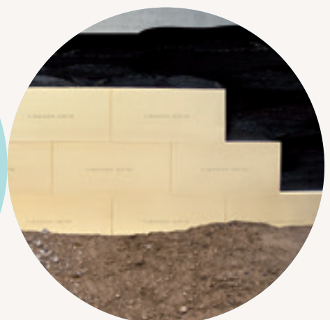
Perimeterdämmung Kelleraußenwand mit URSA XPS
