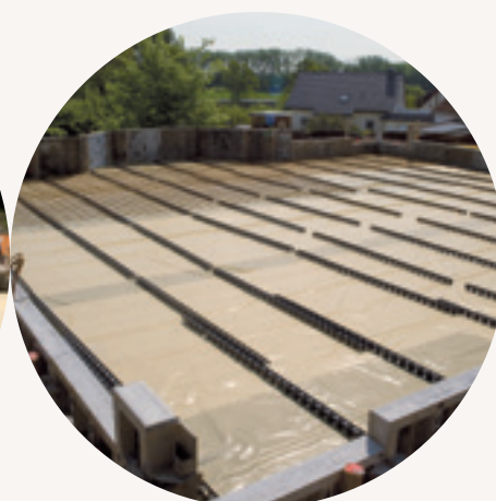
Trennschicht auf der URSA XPS Dämmung mit Abstandshaltern für die Bewehrung
